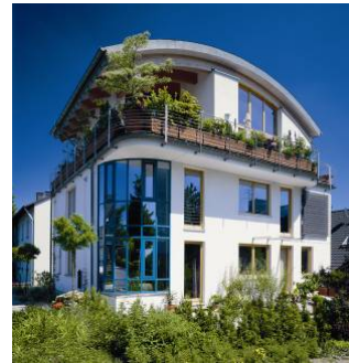
Niedrigenergiegebäude aus Ziegel
