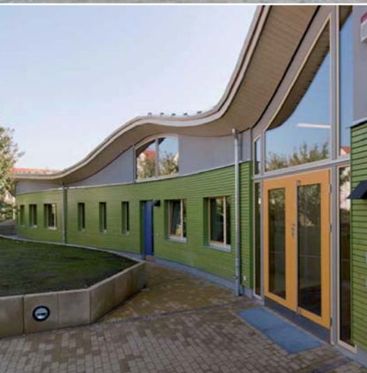
Die Nordansicht mit Haupteingang und dahinter liegenden Funktionsräumen zeigt sich geschlossen und als Lochfassade.
